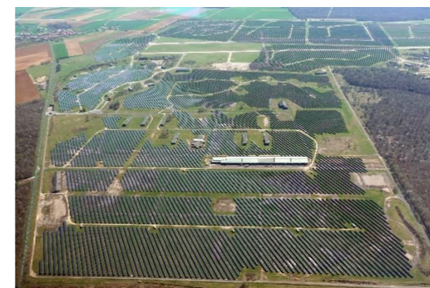
Figure 13 : Centrale solaire de Toul et son antenne de maintenance (54)
